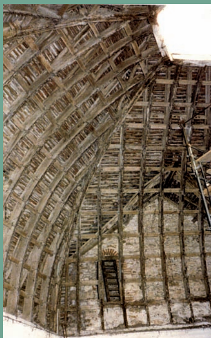
RESTAURATION DE LA CHARPENTE EN 1986
